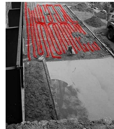
EM DESTAQUE, SISTEMA DE CALEFAÇÃO INSTALADO DURANTE A CONSTRUÇÃO DA CASA (FIGURA MANIPULADA A PARTIR DE FOTOGRAFIA DISPONÍVEL EM: http://jeanprouve.centrepompidou.fr/maison-nancy.php )
