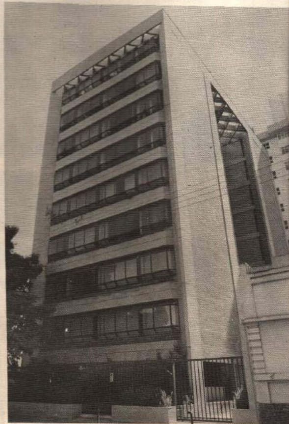
Edifício residencial, Carlos Alberto Viotti.
