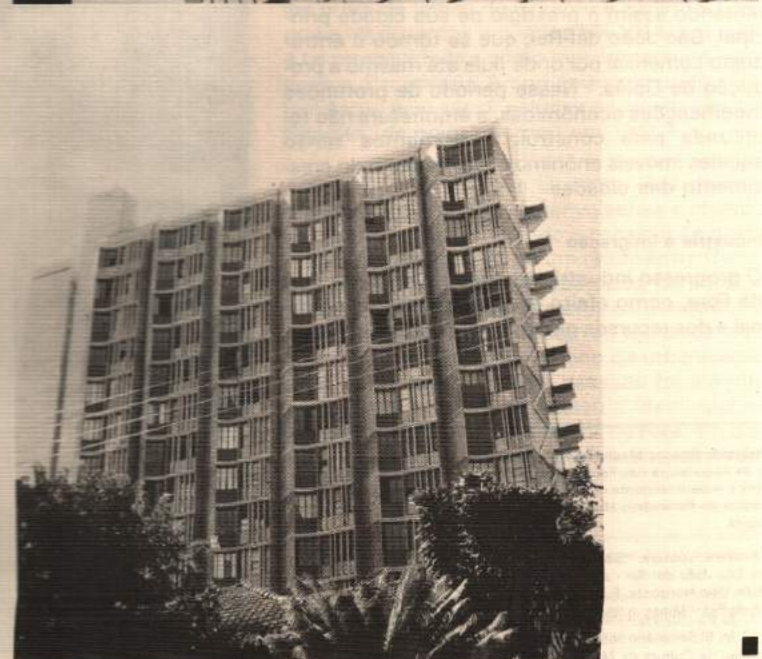
Edifício Serramares, Joel Campolina.
