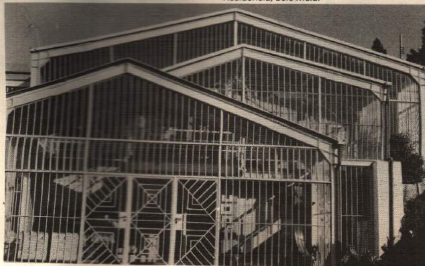
Residência, Éolo Maia.
