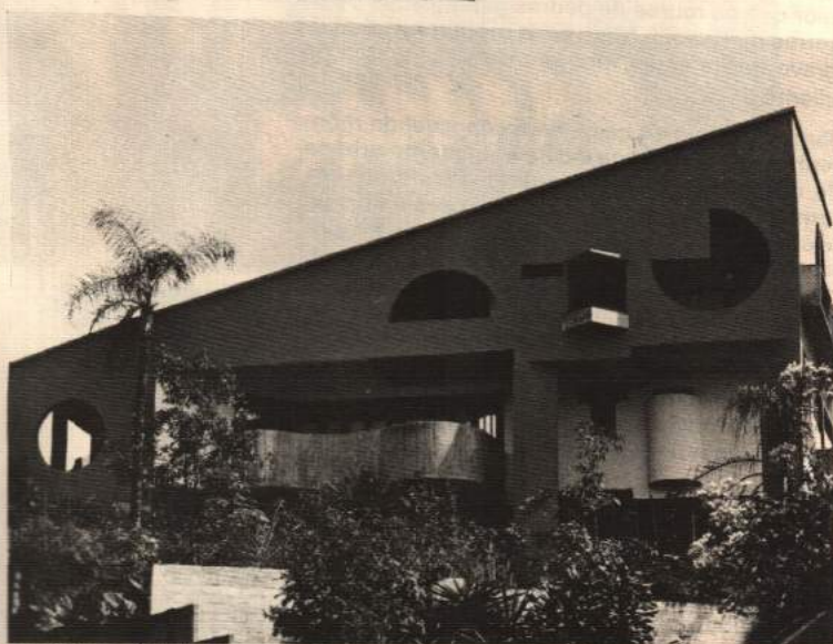
Residência, Éolo Maia.
