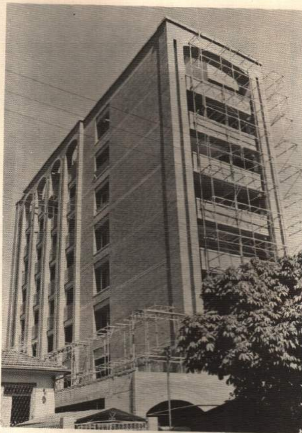
Edifício residencial, Carlos Alberto Viotti.
